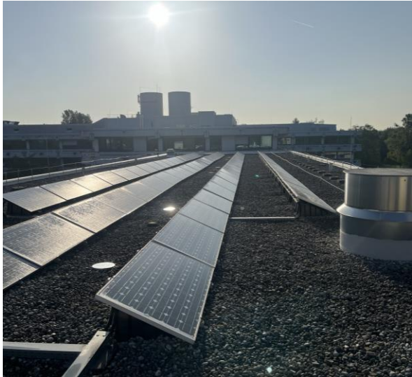
Abbildung 8: Solarmodule auf einem mit Kies bedecktem Flachdach des Max-Planck-Instituts
